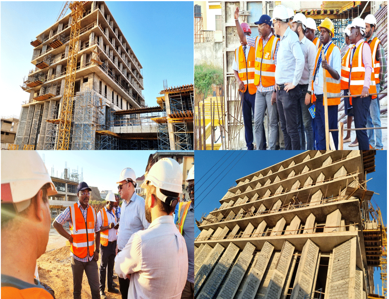
Etat d'avancement des travaux de construction du siège de l'OBR
